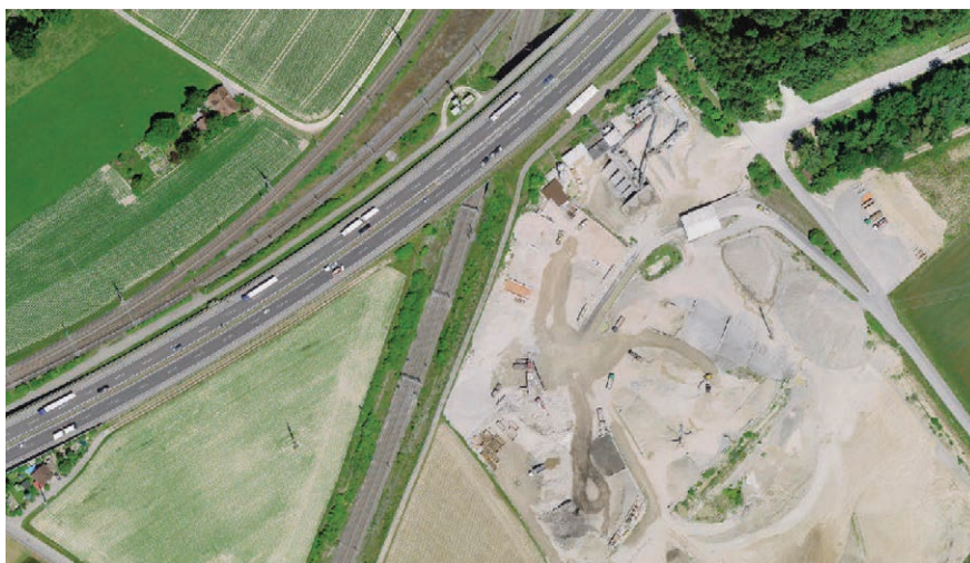
Abb. 14 Zwischen den Bahngleisen und der Strasse sind auf dem Orthophoto entsprechend dem Schutzzonenplan div. Feldgehölze zu erkennen.
